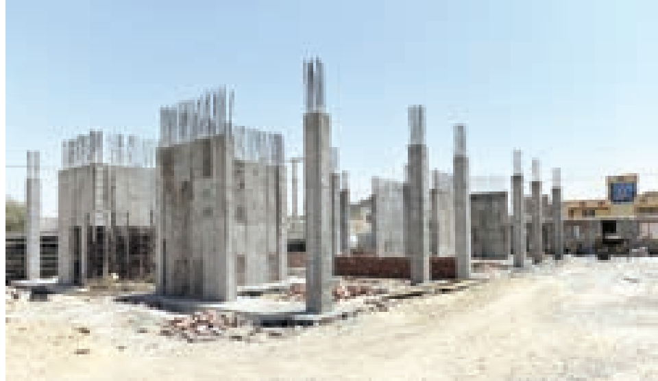
پی‌ریزی ساختمان مدرسه تیس
