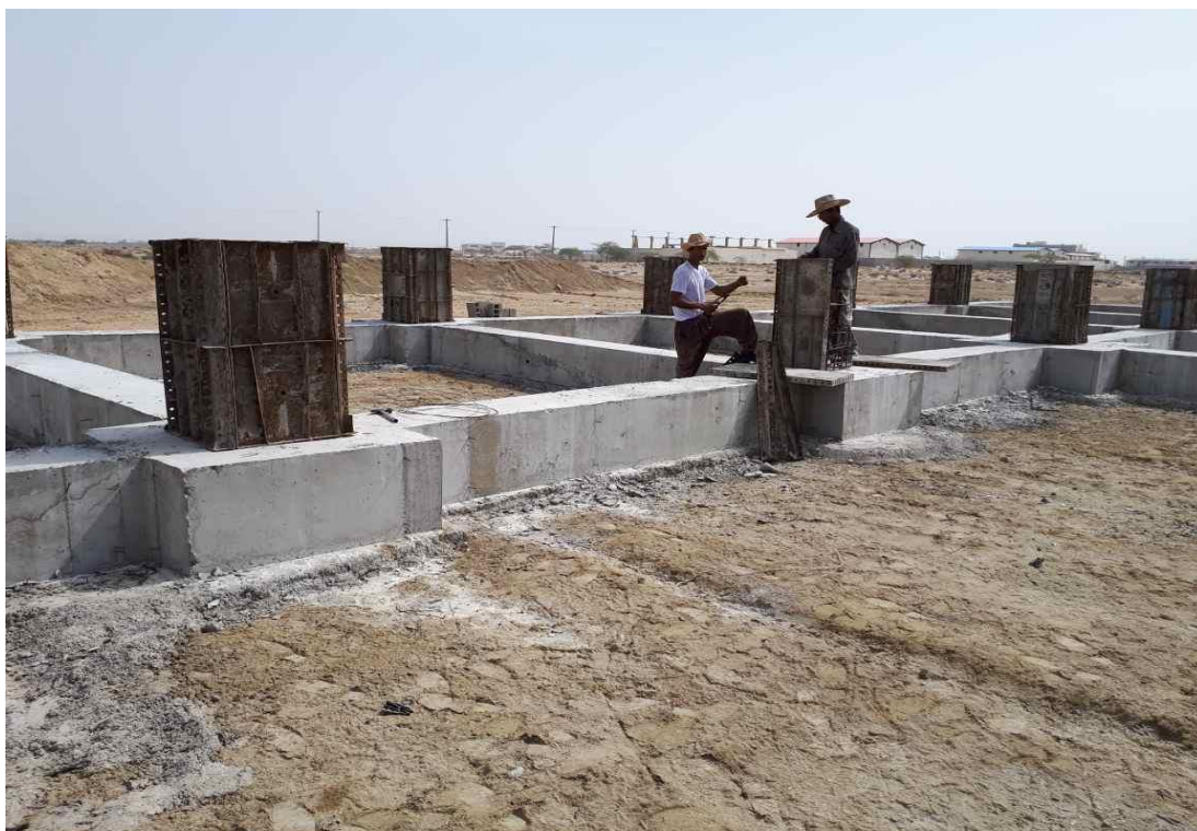
تصویر شماره ۷-۴۴: کارگران مشغول کار در شهرک صنعتی منطقه آزاد چابهار
