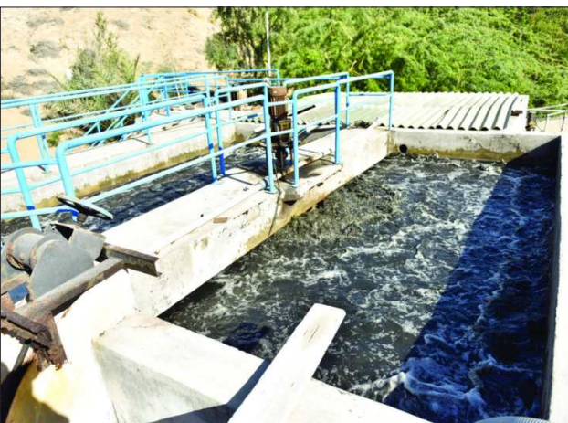
آغاز ساخت تصفیه‌خانه فاضلاب پیکره مسکونی
