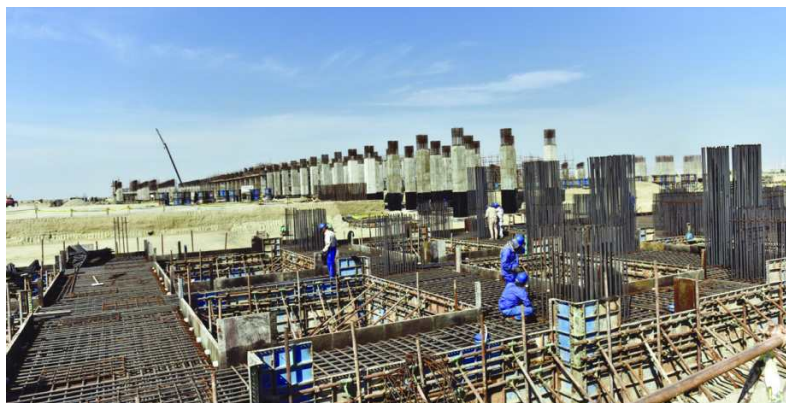
تسریع در عملیات احداث پتروشیمی مپنا
